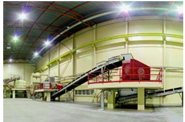
»2 Line-A preparation »2 Aufbereitung der Linie A
